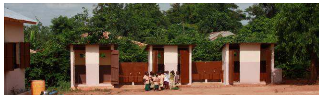
Construction d'urinoirs et de lavabos, adduction d'eau potable. Ici à l'école maternelle d'Adjohoun
