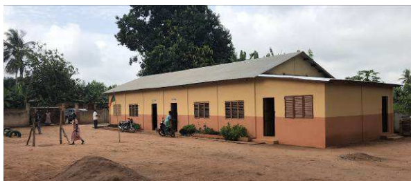
Construction de la maternelle d'Ayou
