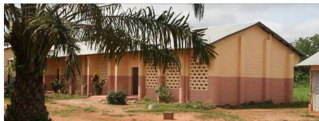
Construction et rénovation de bâtiments Ici à l'école primaire de Gbékandii II
