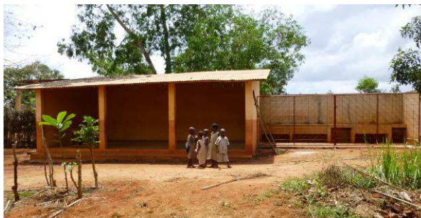
Construction d'un abri cantine et de lavabos à l'école primaire de Tegbo
